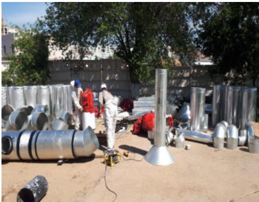
Капитальный ремонт вентиляционной системы КНС-15
