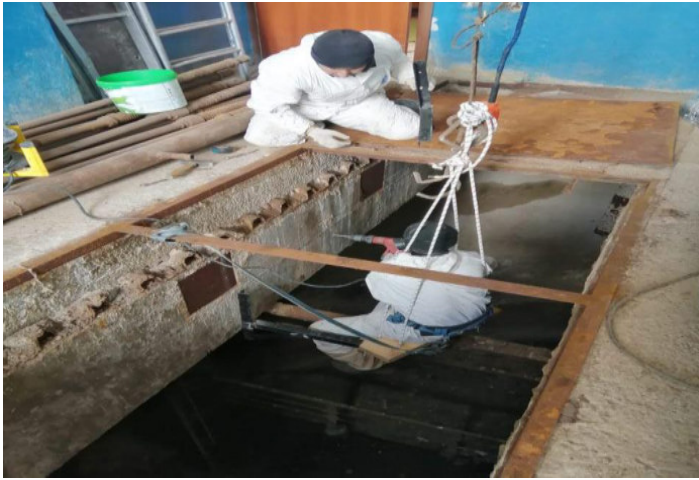
Капитальный ремонт вентиляционной системы КНС-15
