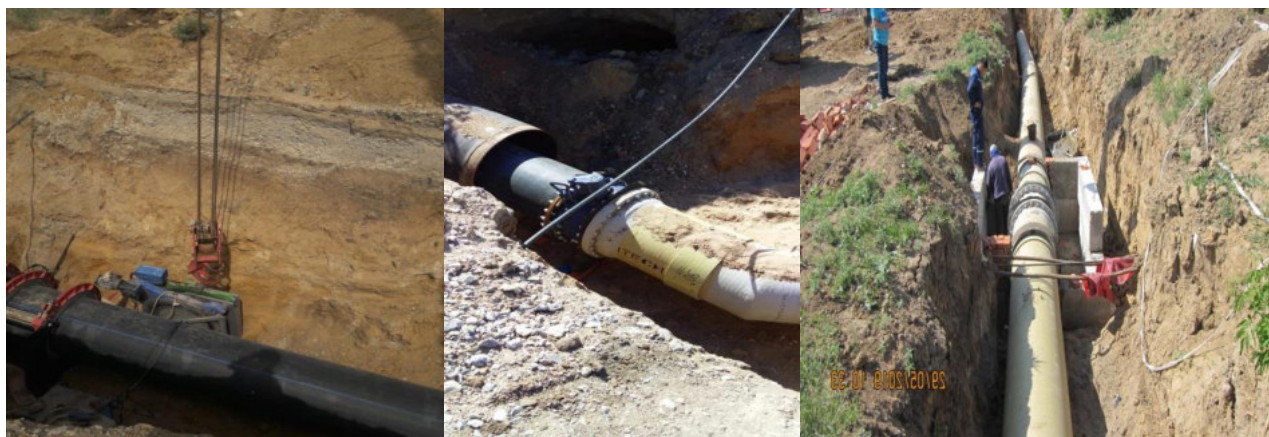
2. Капитальный ремонт водовода Д-800 мм от ВОС до ТЭЦ, в г. Актобе
