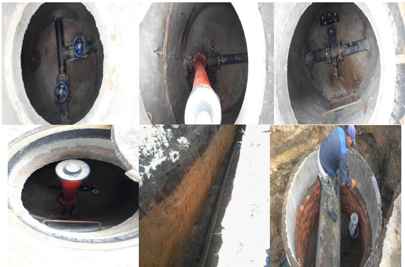
2. Капитальный ремонт водовода Д-800 мм от ВОС до ТЭЦ, в г. Актобе
