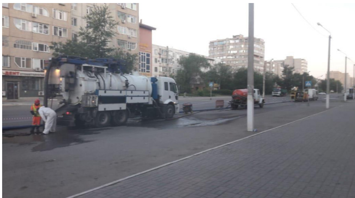
5. Капитальный ремонт самотечной канализации д-500мм от ул. Сатпаева по ул. Рыскулова – пр. А. Молдагуловой до КНС 6
