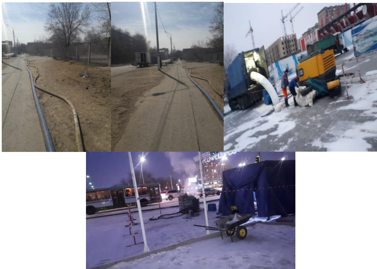
6. Перебуривание существующих скважин №1 и №3 водозабора п. К. Нокина
